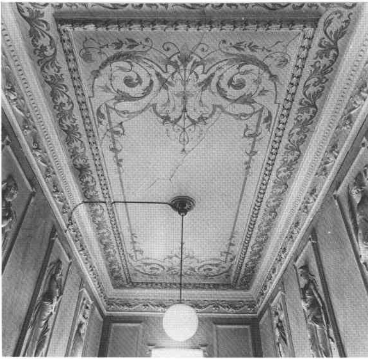
Karlavagnen 11, takmålning i entré.
